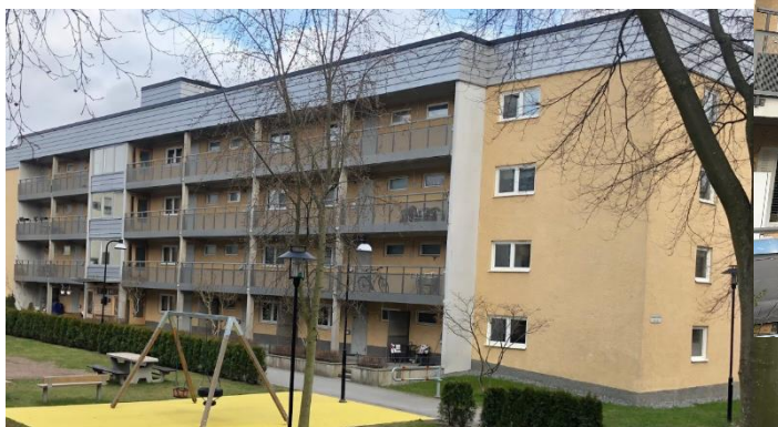
Figur 3. Ovanstående är exempel på tidigare genomförda renoveringar i området som godkänts. Flertal föreningar har valt att ha perforerade plåtar istället för de bullriga sinusplåtarna för bättre insyn och trygghet.
